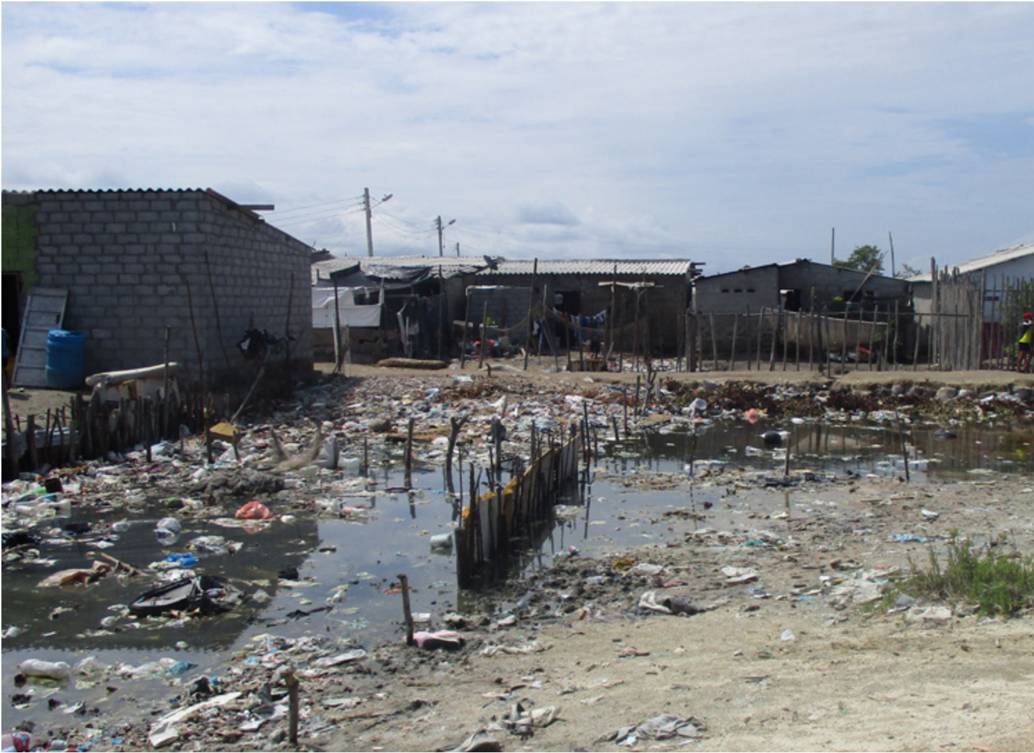
Preparando la ciénaga para la construcción de vivienda /Astrid Lorena Perafán, 6 de octubre de 2018
