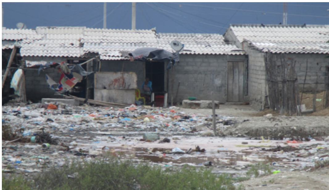
Viviendas construidas en zona de relleno /Ariel Fernando Amado, 7 de octubre de 2018
