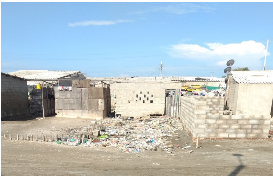
Relleno con residuos sólidos de diversos orígenes para construcción de viviendas /Elgher Benjamín Pacheco, 19 de septiembre de 2018
