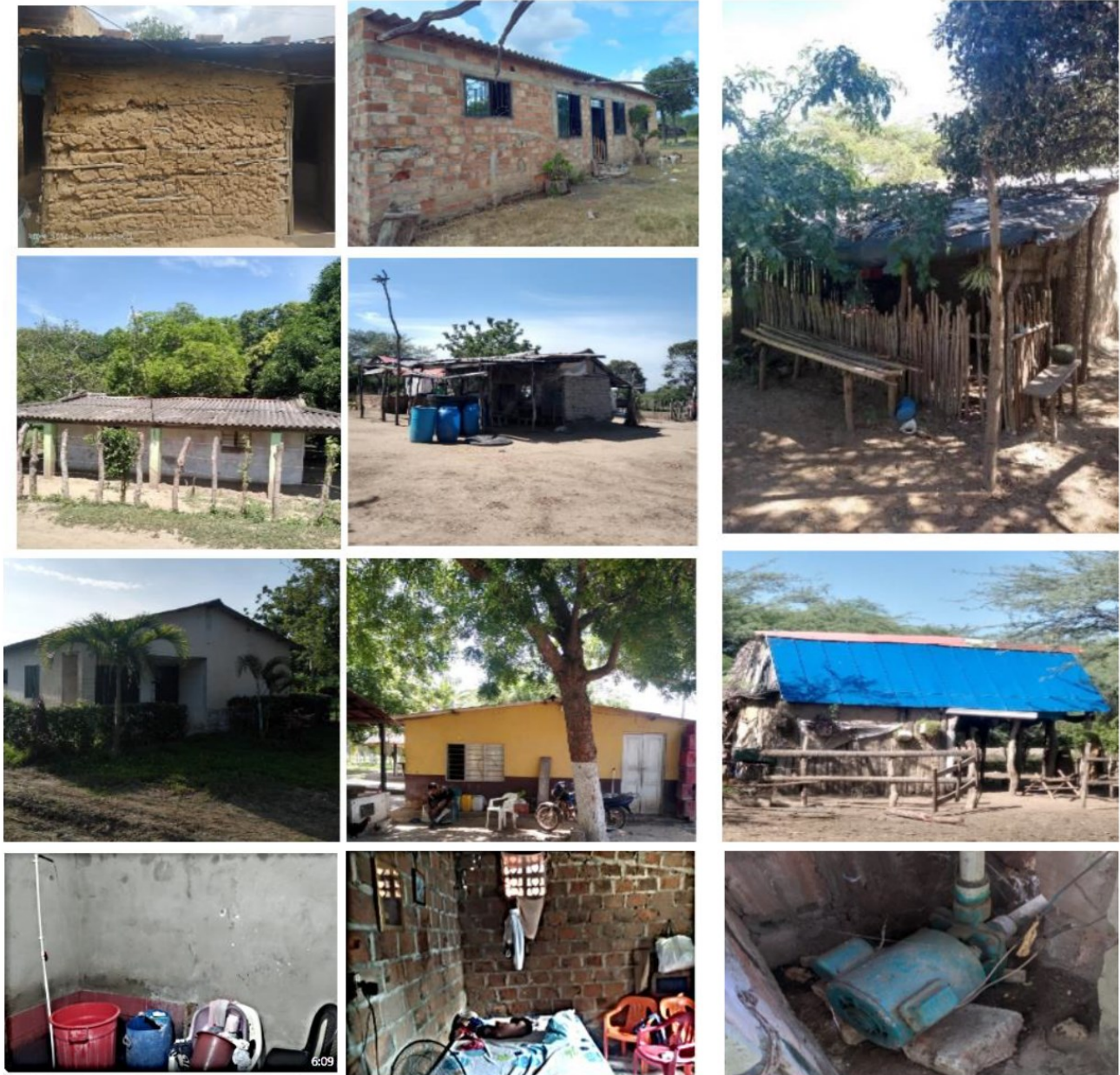
Figura 5. Tipo de viviendas unidades productivas zona de estudio. Grupo técnico proyecto cambio climático).
