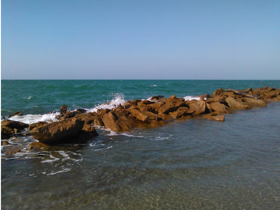
Figura 1. Rompeolas construido con roca caliza. Coveñas, Sucre, Colombia.
